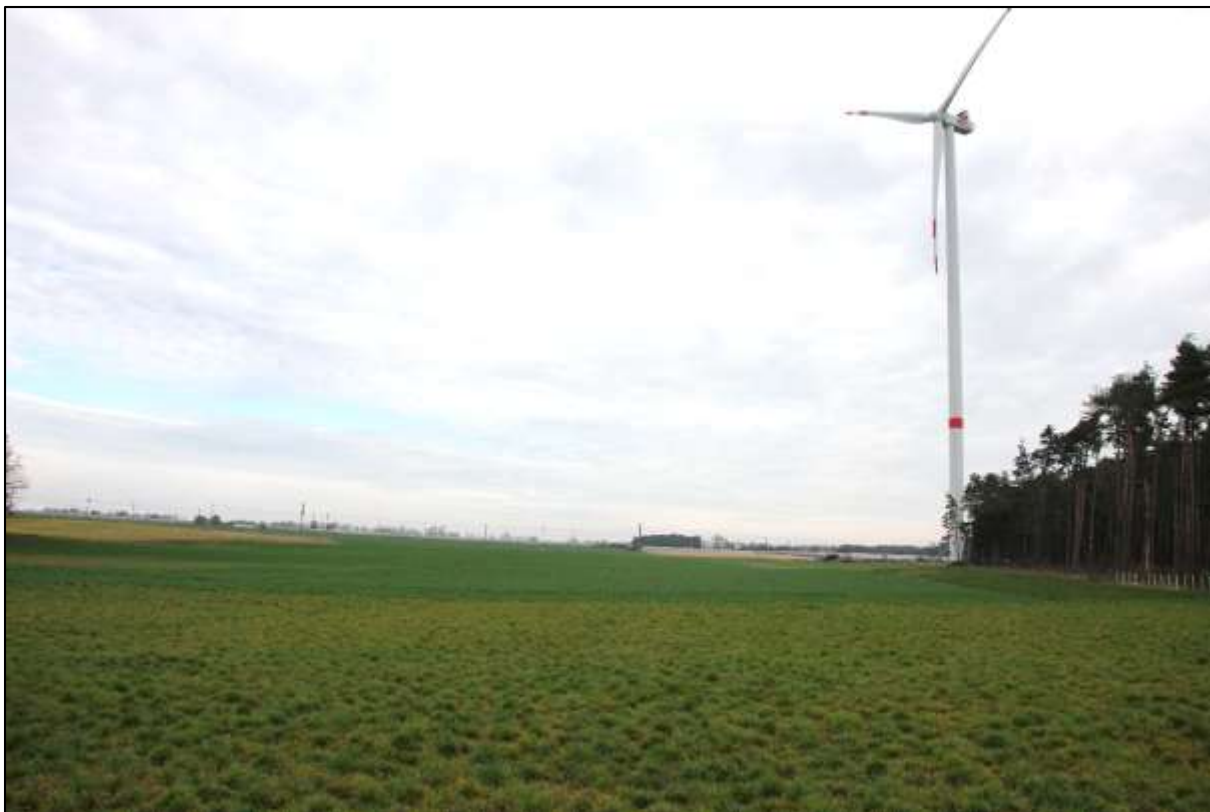
Abbildung 4: Blick von Süd nach Nord über den Planungsbereich. Foto: M. Bull, 22.03.2024.
